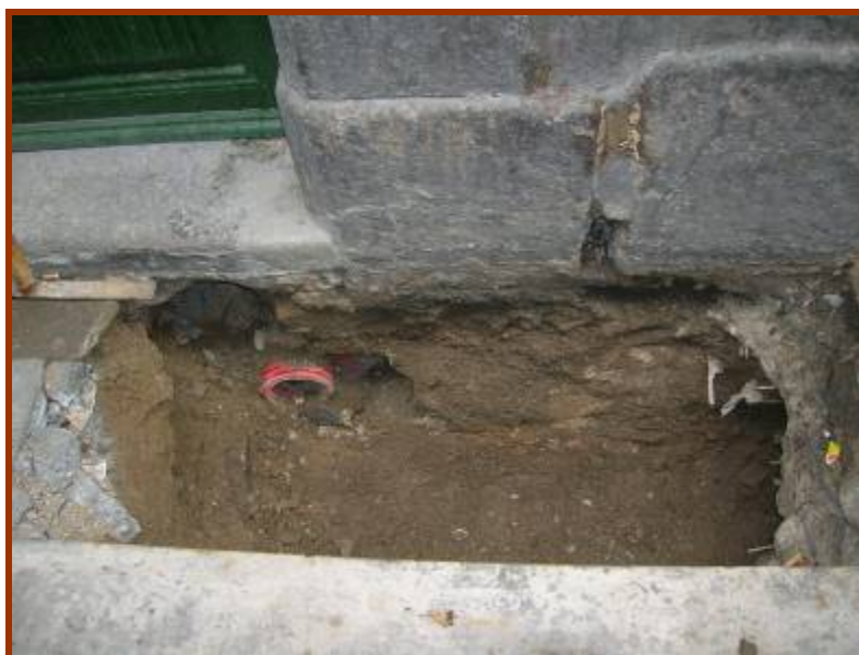
Fotografia 4. Accés nova línia de BT a la finca Sant Ramon 5
